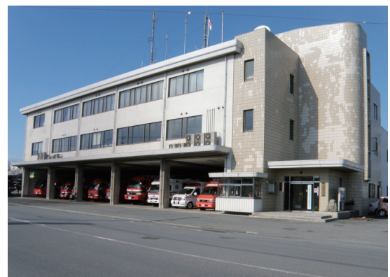
消防局、宇部中央消防署庁舎
